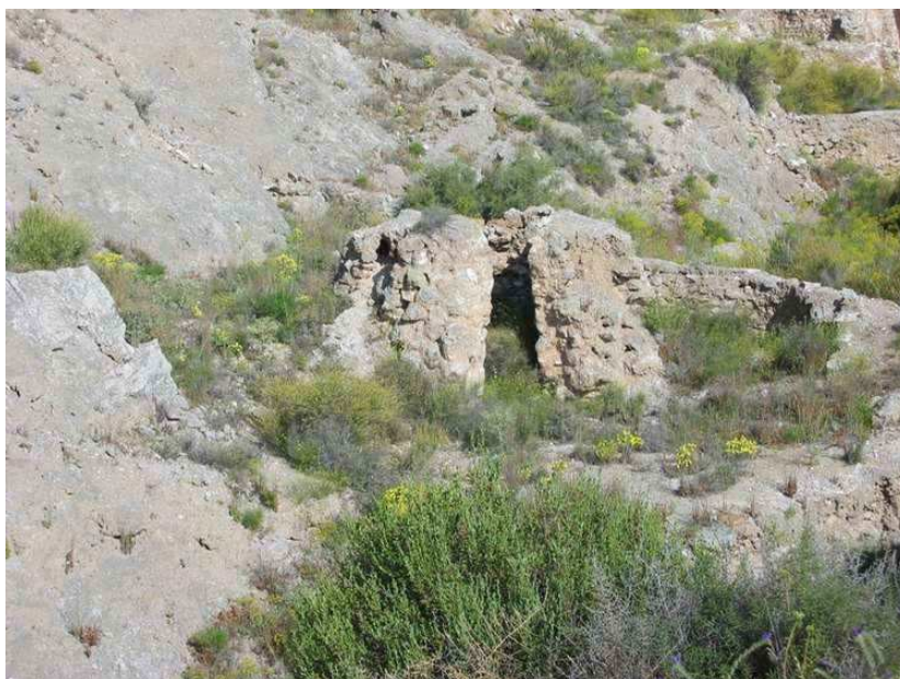
Horno 2. Estructura principal y adjunta a la derecha
