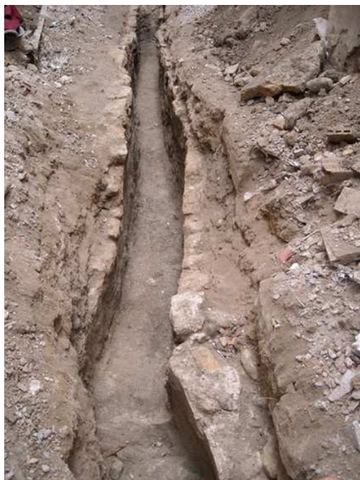
Muros UE 5 y UE 6 de la canalización
