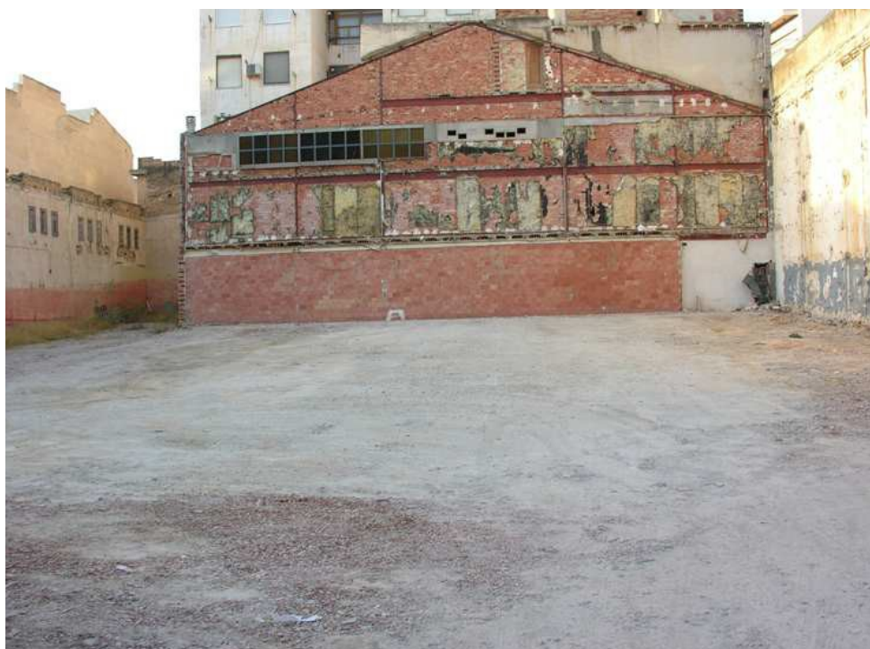
Vista del solar antes de iniciar la actuación
