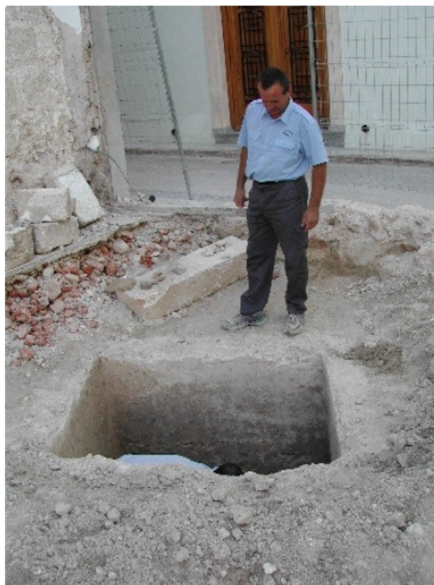
Excavació de l'aljub
