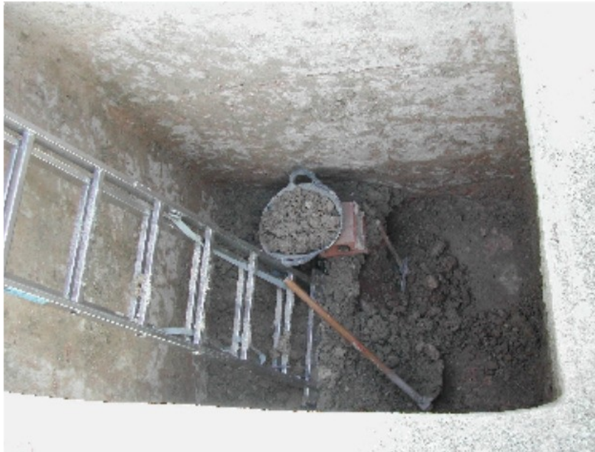
Detall de l'aljub durant l'excavació
