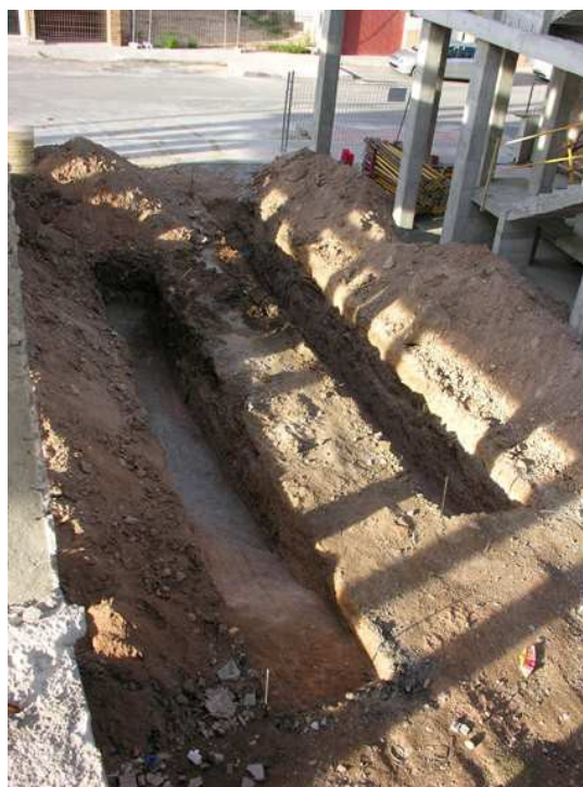
Vista del solar al final de la excavación
