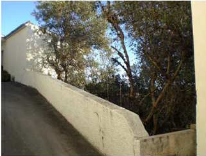
Foto inicial. Fachada del solar a la calle Santa Ana.
