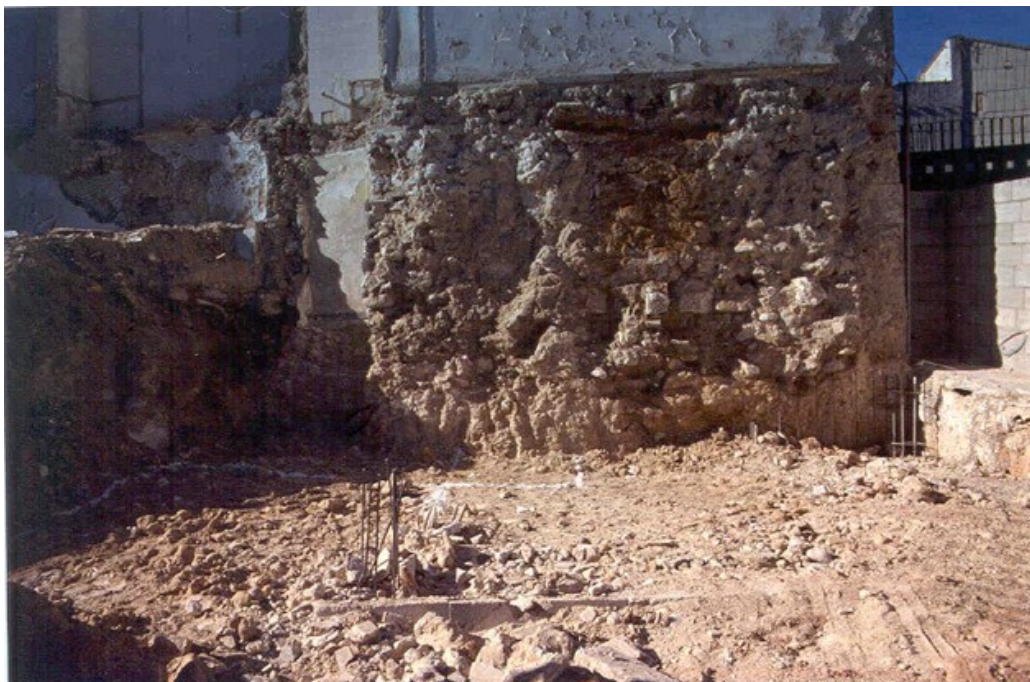
Vista general del solar
