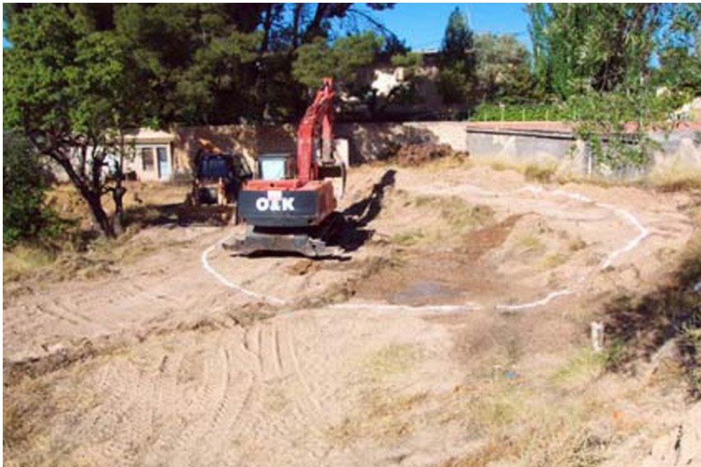
Inicio del rebaje y excavación para la instalación de la balsa prefabricada
