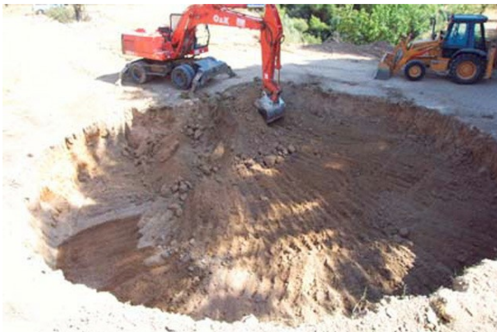
Fase final de los trabajos de excavación
