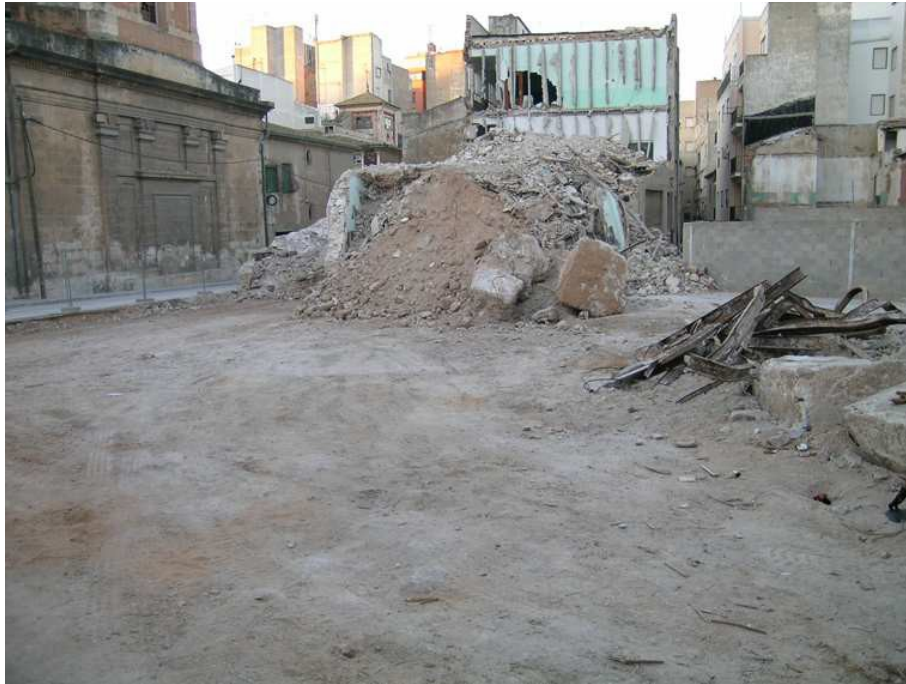
Vista parcial del solar antes de iniciar la excavación
