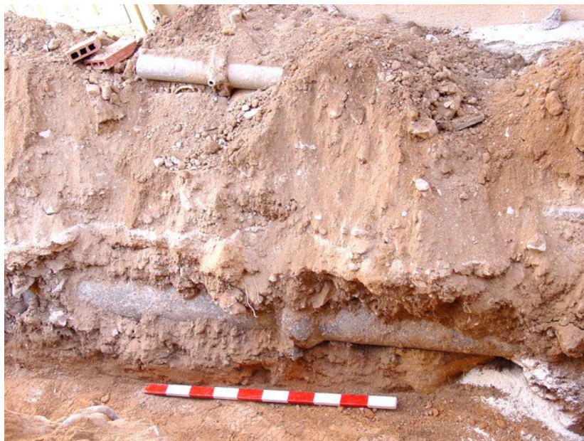
Parte del alcantarillado sustituido
