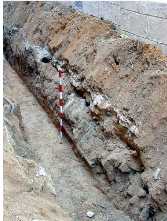
Detalle de la profundidad de la zanja
