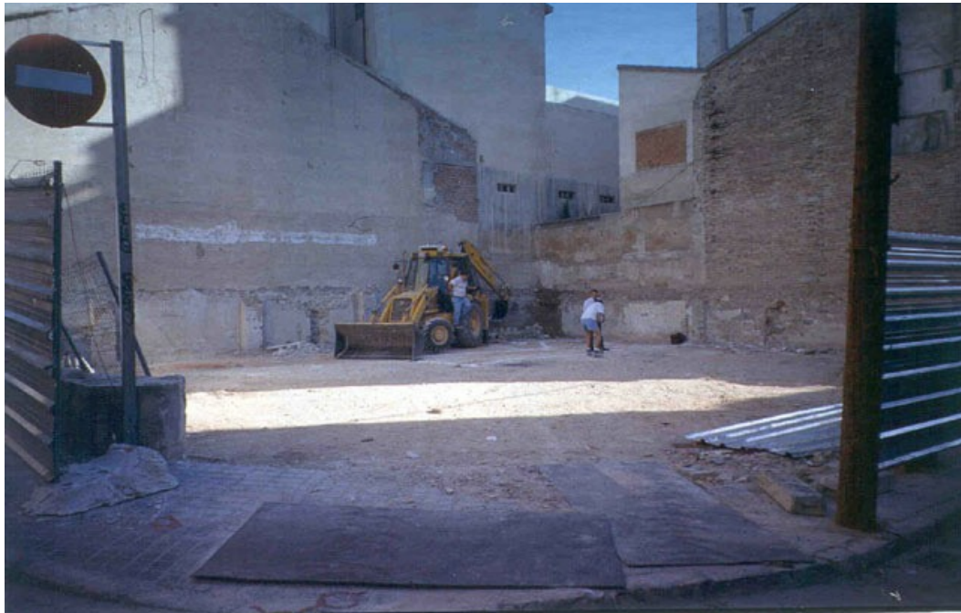
Vista general del solar abans de l'inici dels moviments de terra
