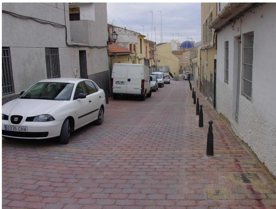
Calle San Hermenegildo tras la obra de urbanización
