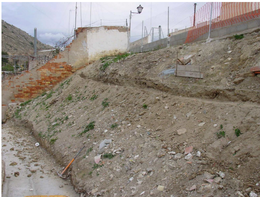
Limpieza, desbroce y zanja para situar el murete de contención del relleno
