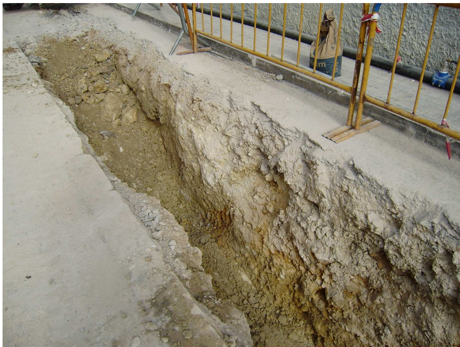
Estratigrafía en la zanja para el alcantarillado en la calle San Hermenegildo
