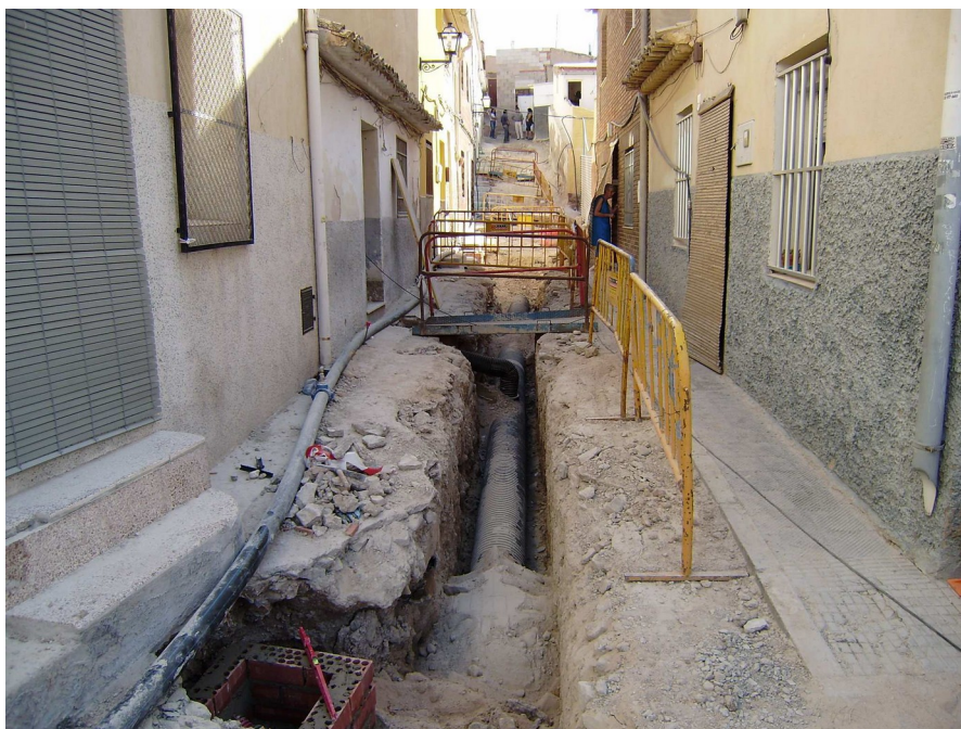
Zanja central para el alcantarillado en la calle San Hermenegildo
