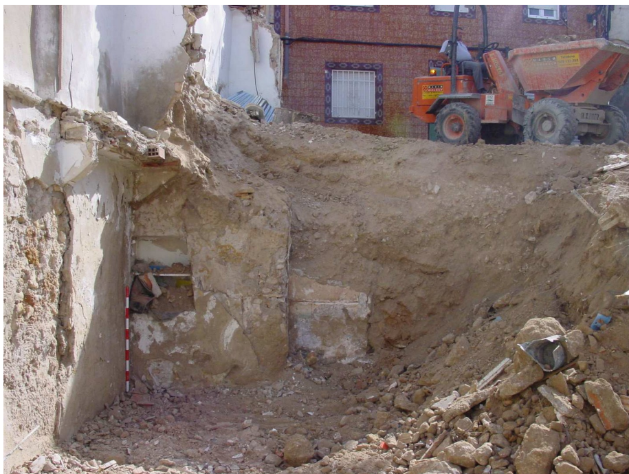
Retirada de escombros. Se documentó una alacena de la vivienda contemporánea
