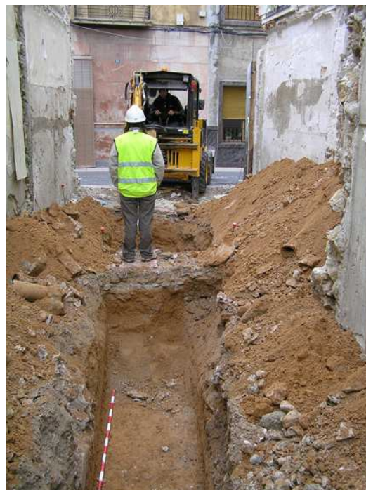
Proceso de excavación del Sondeo 1
