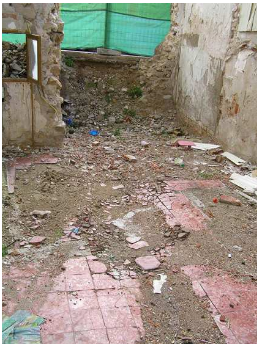
Vista del solar antes de la intervención
