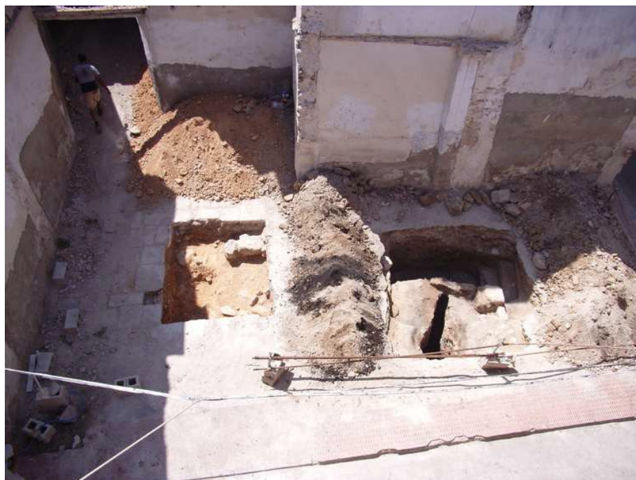
Vista general del final de la excavación
