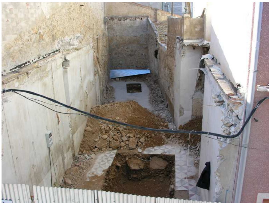
Vista general del solar y del final de la excavación
