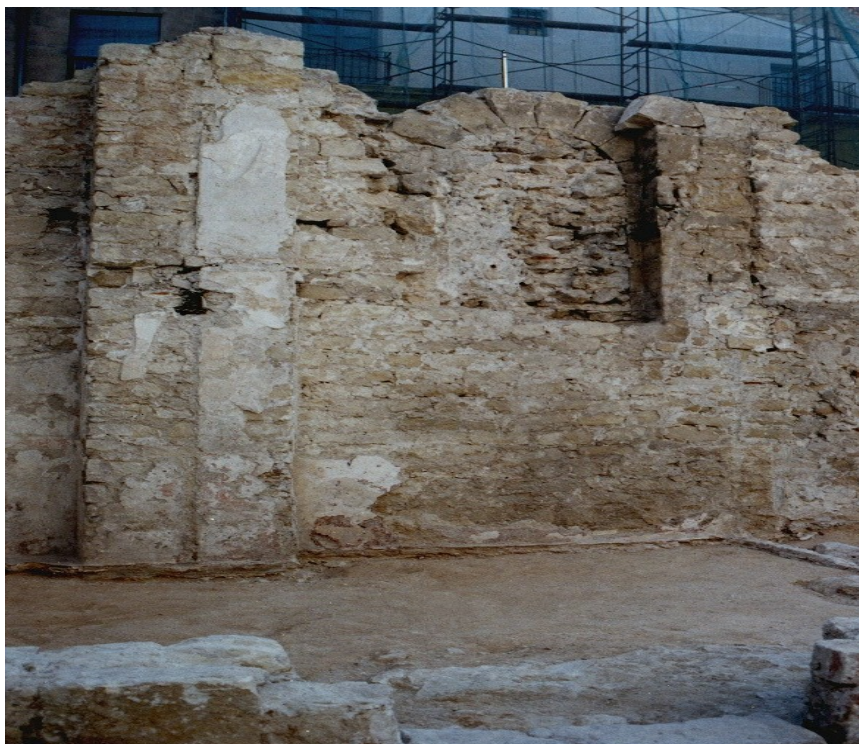
Vista de uno de los ingresos del edificio de época bajomedieval
