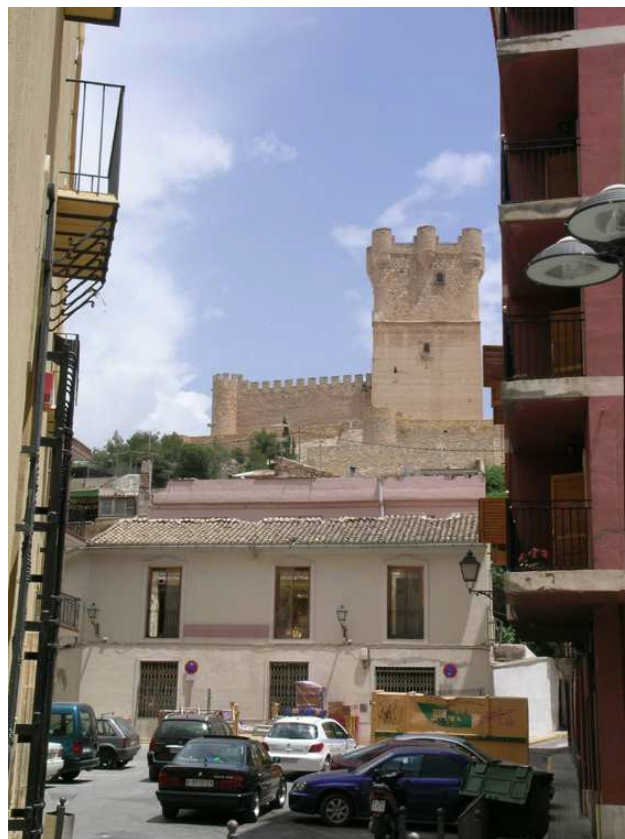
En primer término, el inmueble objeto de intervención
