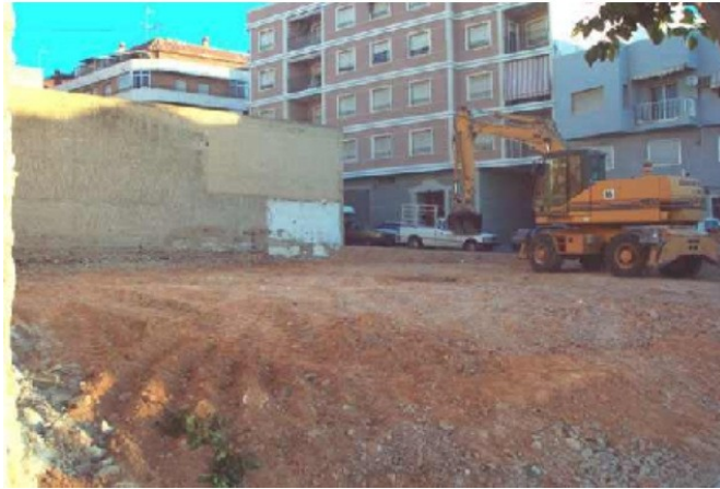
Solar antes de los trabajos de excavación
