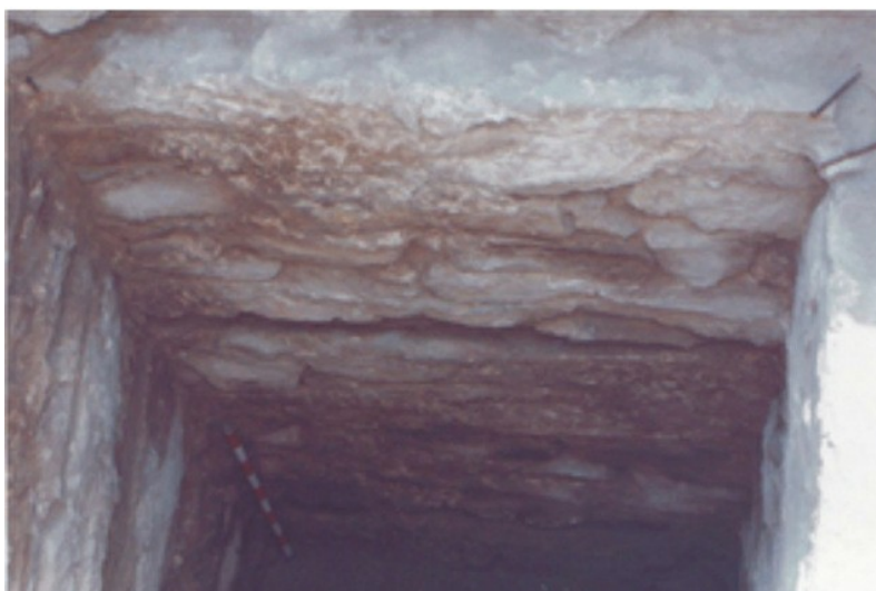
Detalle de la excavación
