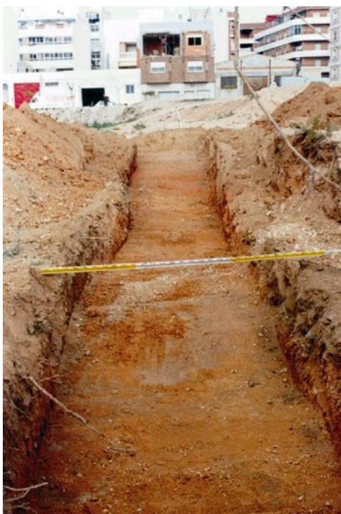
Sondeo 5 desde el sur
