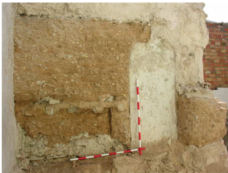
Muros de tapial
