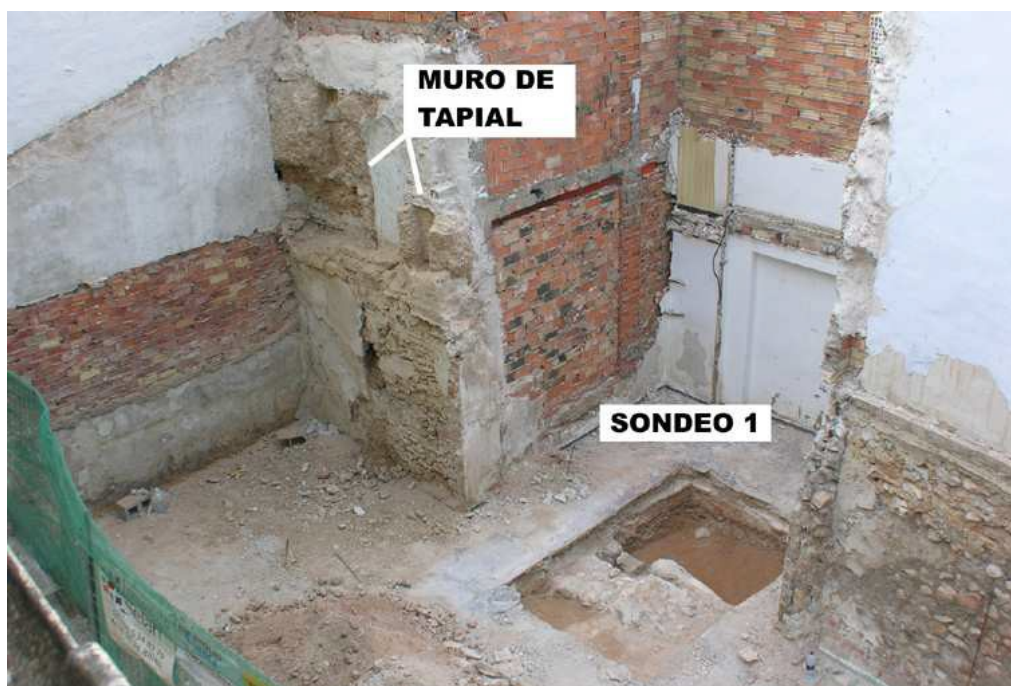
Vista final de la excavación: Sondeo 1 y muros de tapial
