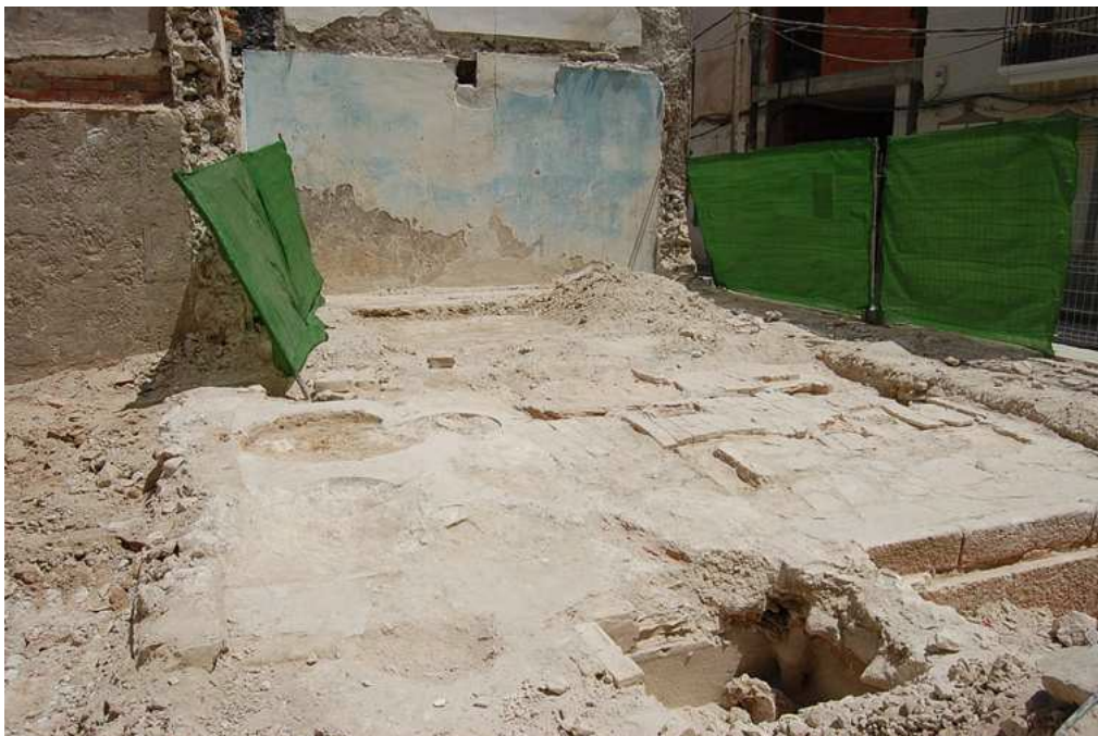
Estado inicial del solar tras la limpieza del mismo
