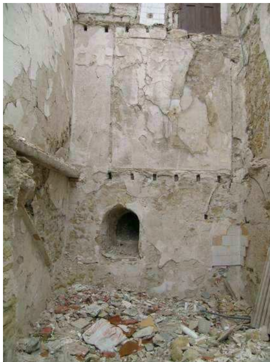
Estado previo del solar
