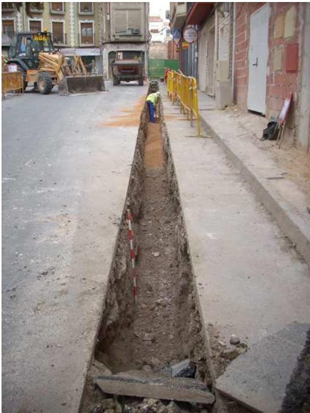
Vista parcial de la zanja excavada
