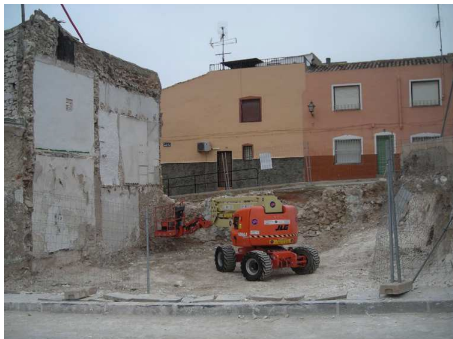
Proceso de retirada de escombros del derribo
