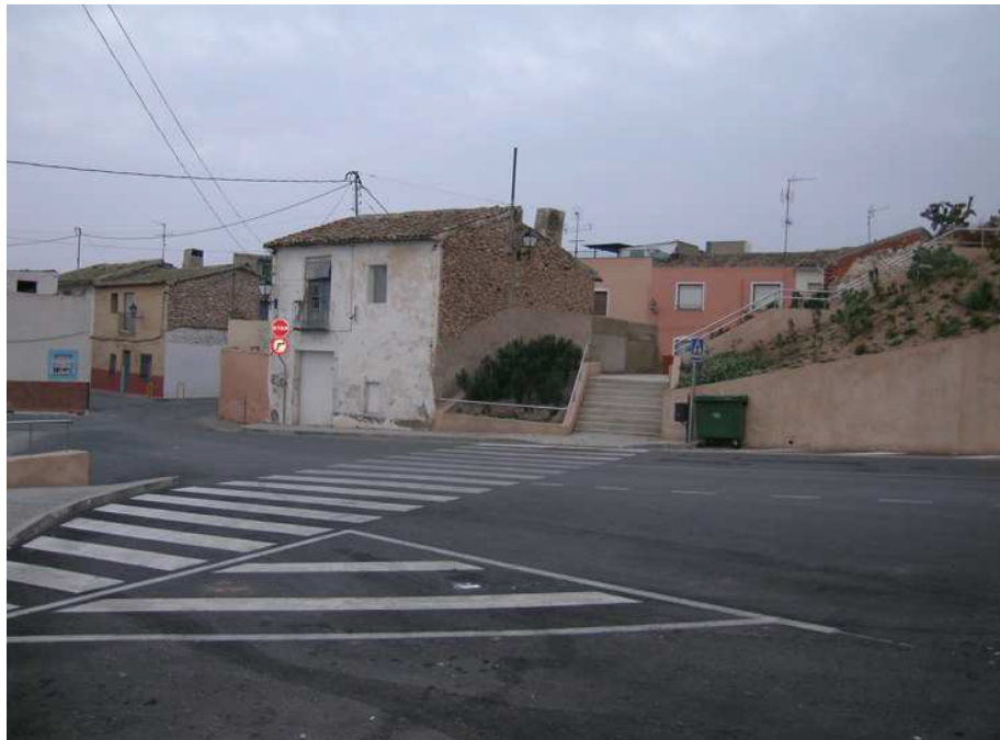
Vista de la vivienda original derribada
