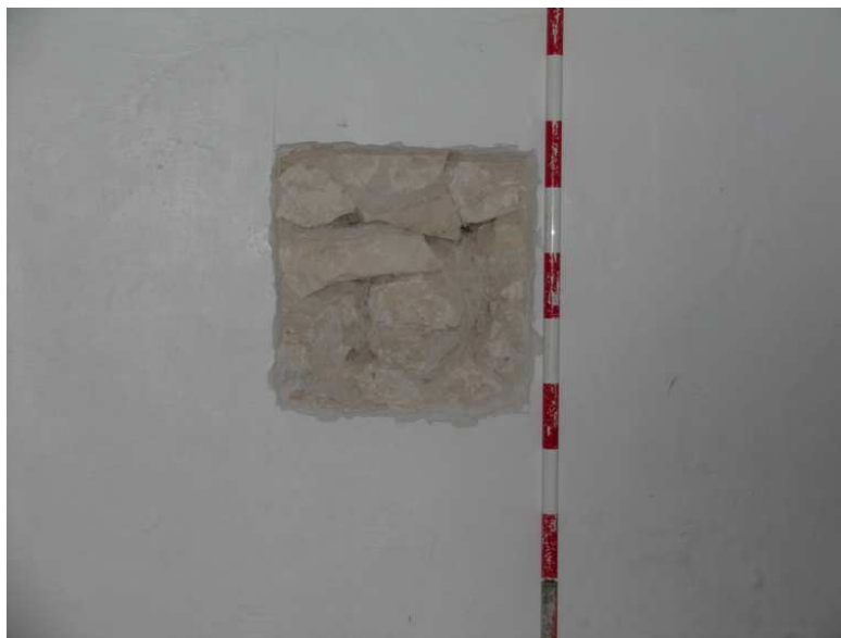
Detalle de cata muraria
