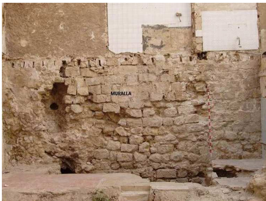
Detalle de la muralla
