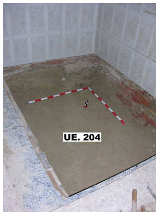
Vista del Sondeo 2 una vez finalizado
