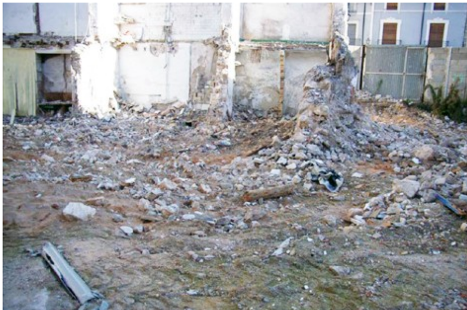
Vista general del solar con la zona donde se realizaron los sondeos 1 y 2
