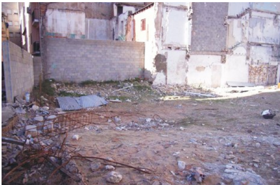
Vista general del solar con la zona donde se realizaron los sondeos 3 y 4
