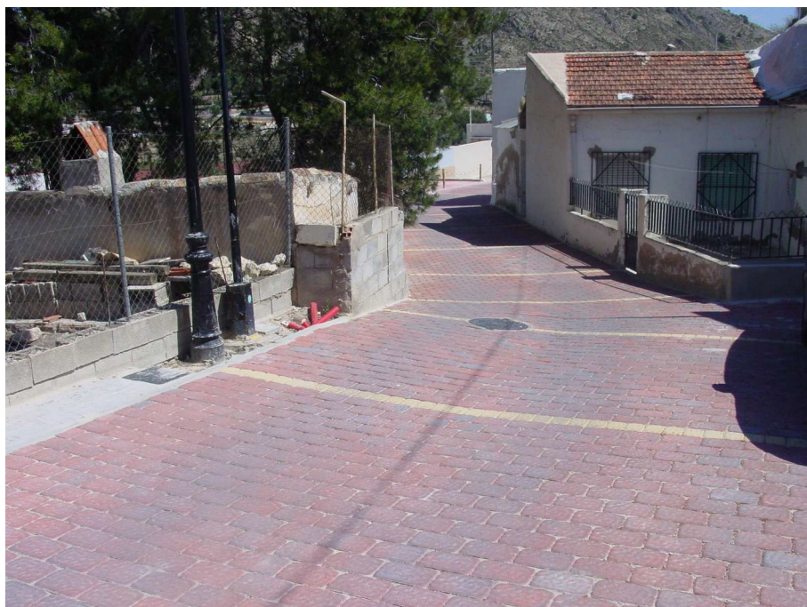
Vista de la calle Cuevas del Castillo con la obra finalizada
