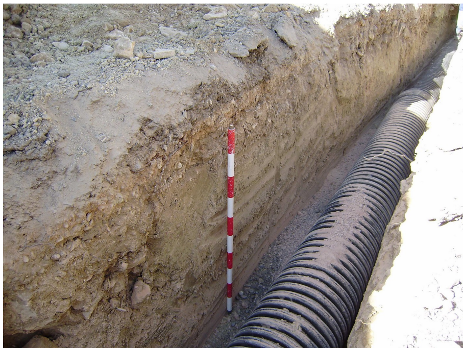
Estratigrafía y tubería de alcantarillado en la calle Cuevas del Castillo
