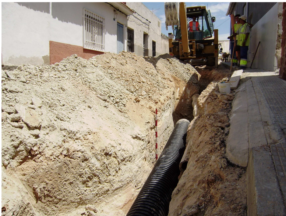
Zanja para la tubería de alcantarillado y estratigrafía de la calle Casas del Castillo
