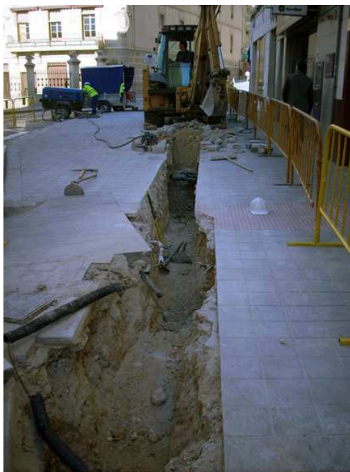
Zanja en proceso de excavación
