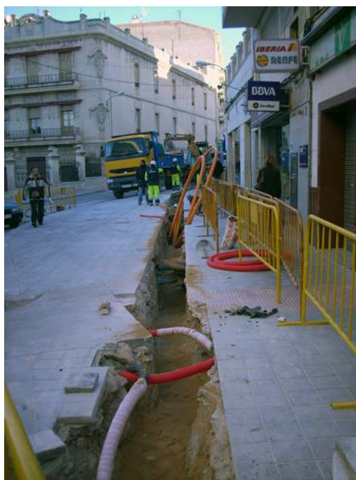
Vista parcial de la zanja tras la excavación
