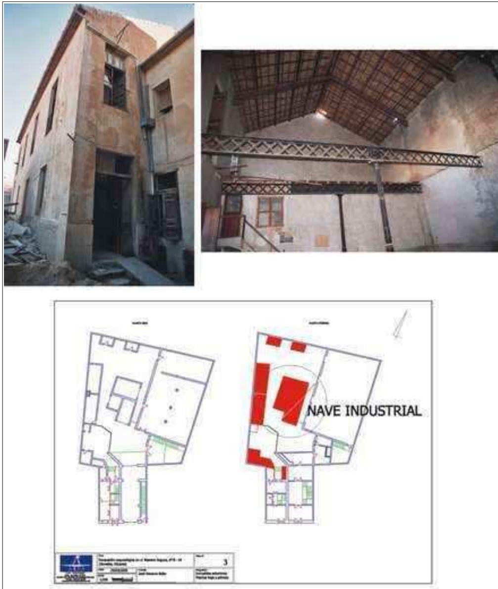
Nave industrial ubicada en el patio de la próxima construcción
