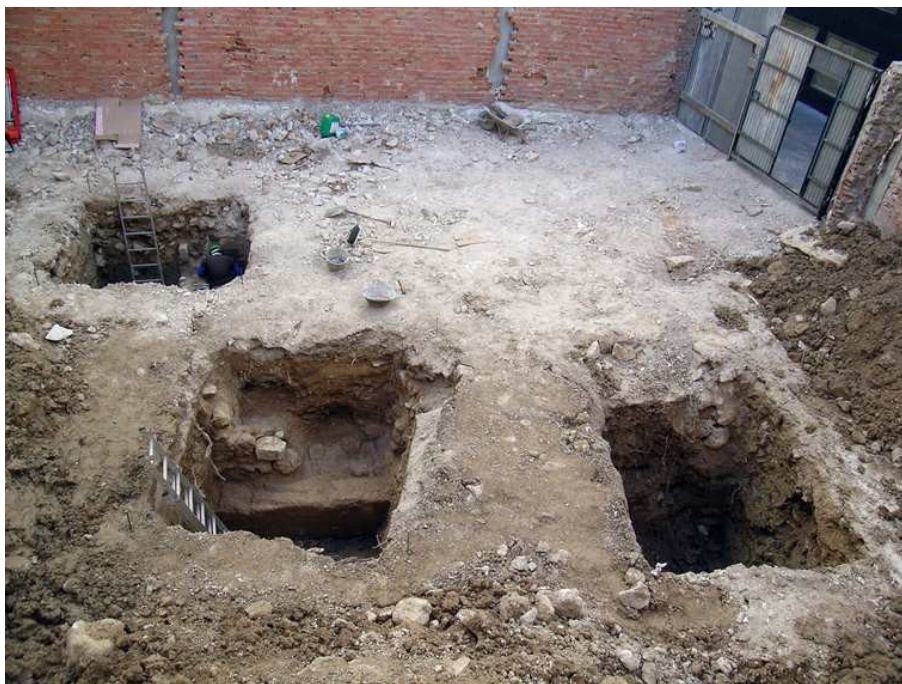
Vista general de la excavación
