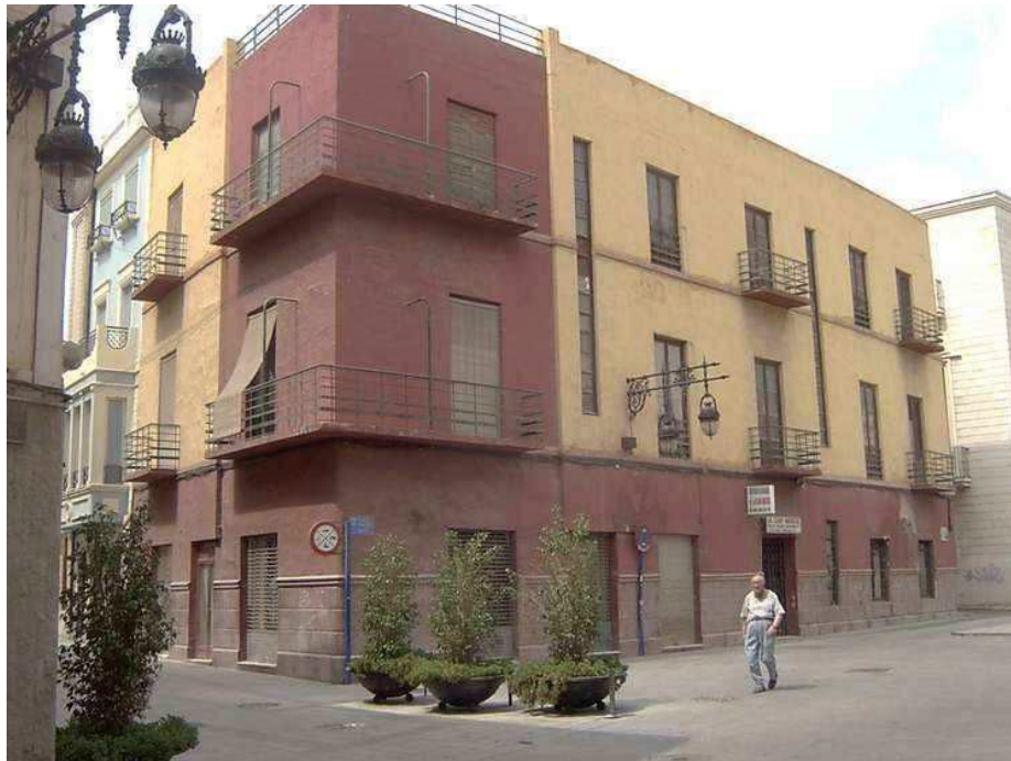
Vista del inmueble desde la plaza del Teniente Linares
