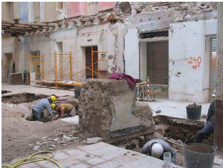
Interior del inmueble y proceso de excavación
