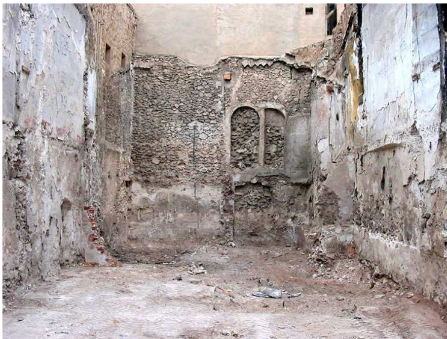
Vista del solar de la calle Empedrada, 5 antes de realizar la excavación
