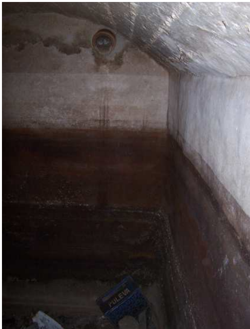
Interior del aljibe
