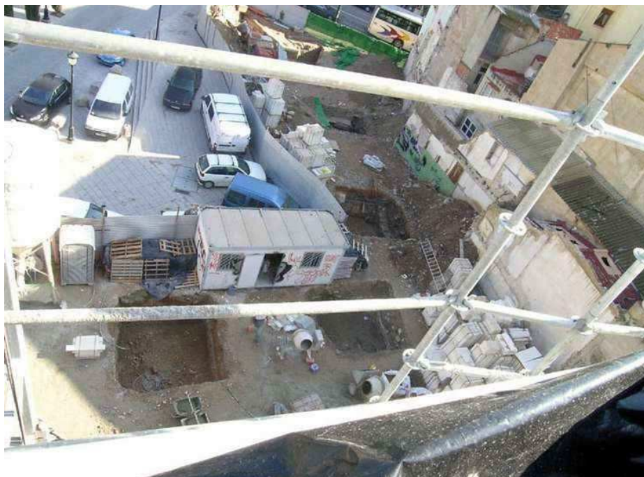
Vista general de los sondeos
