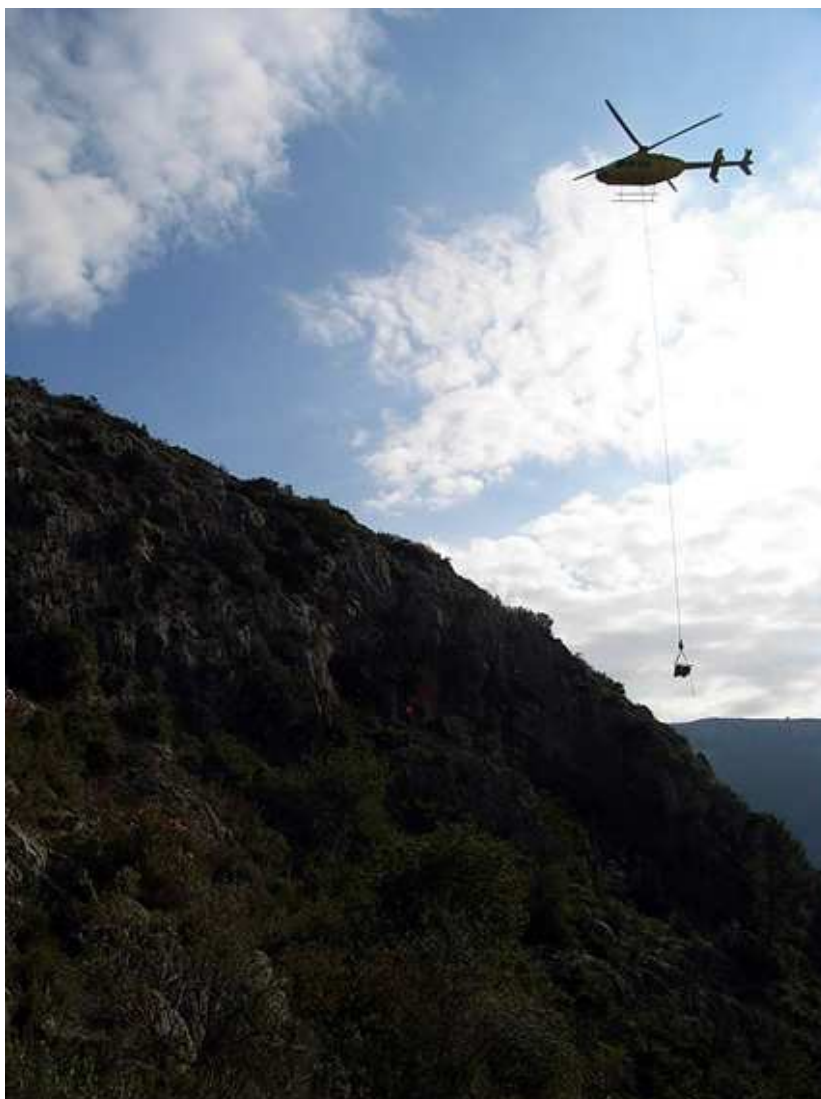
Traslado de materiales en helicóptero al abrigo
