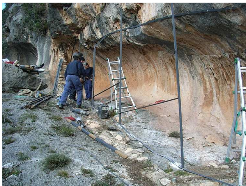
Trabajos previos a la instalación de la valla de cerramiento del abrigo
