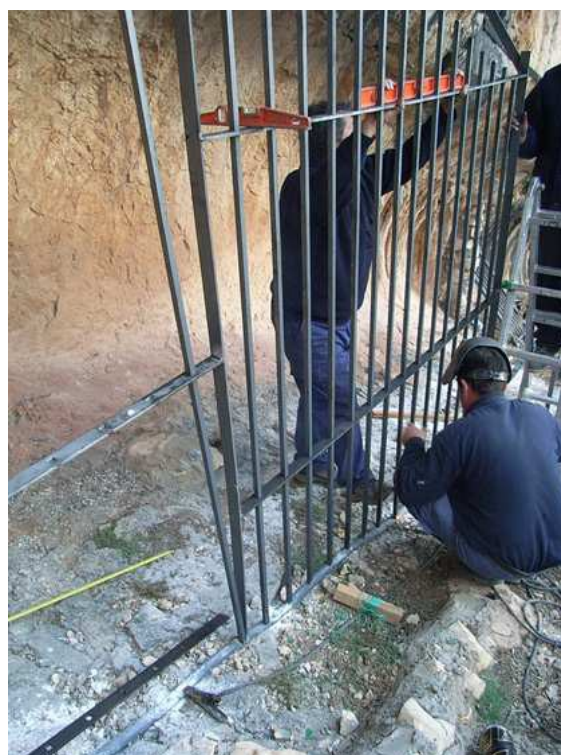
Instalación de la valla metálica
