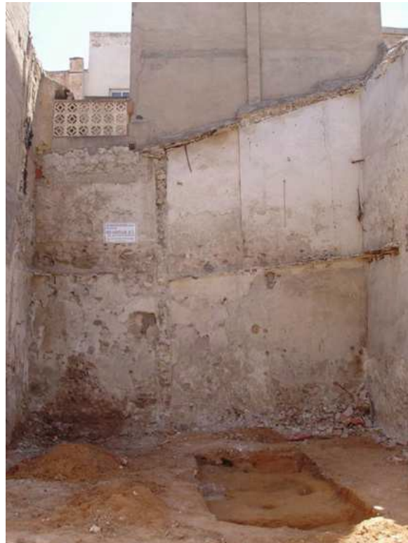
Vista general con uno de los sondeos
