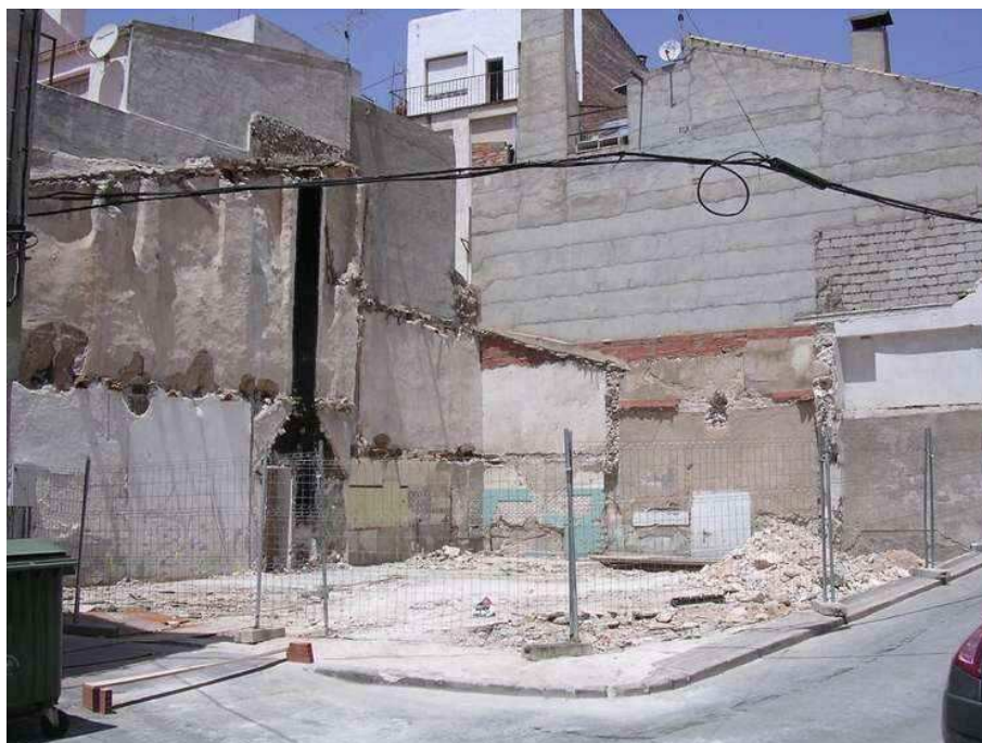
Vista general del solar desde la calle San Antón
