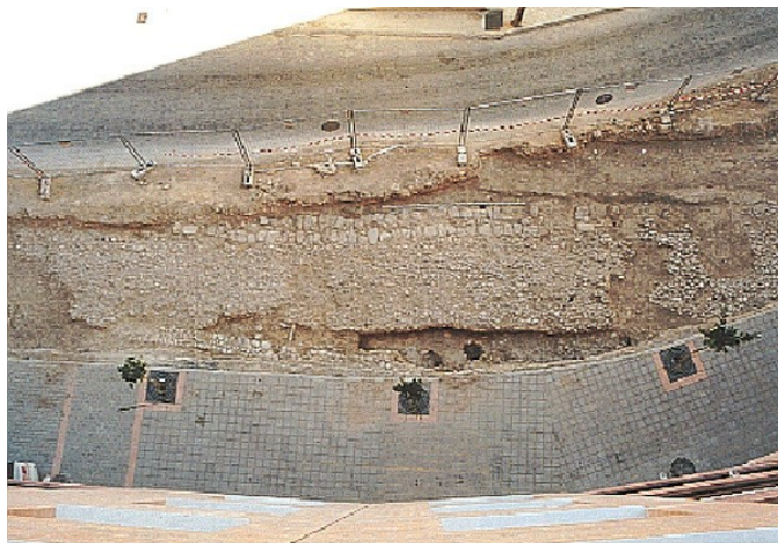
Área Este. Vista general del camino
