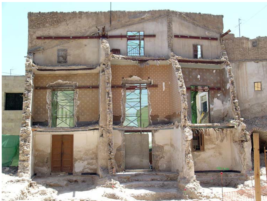
Fachada de excavación
