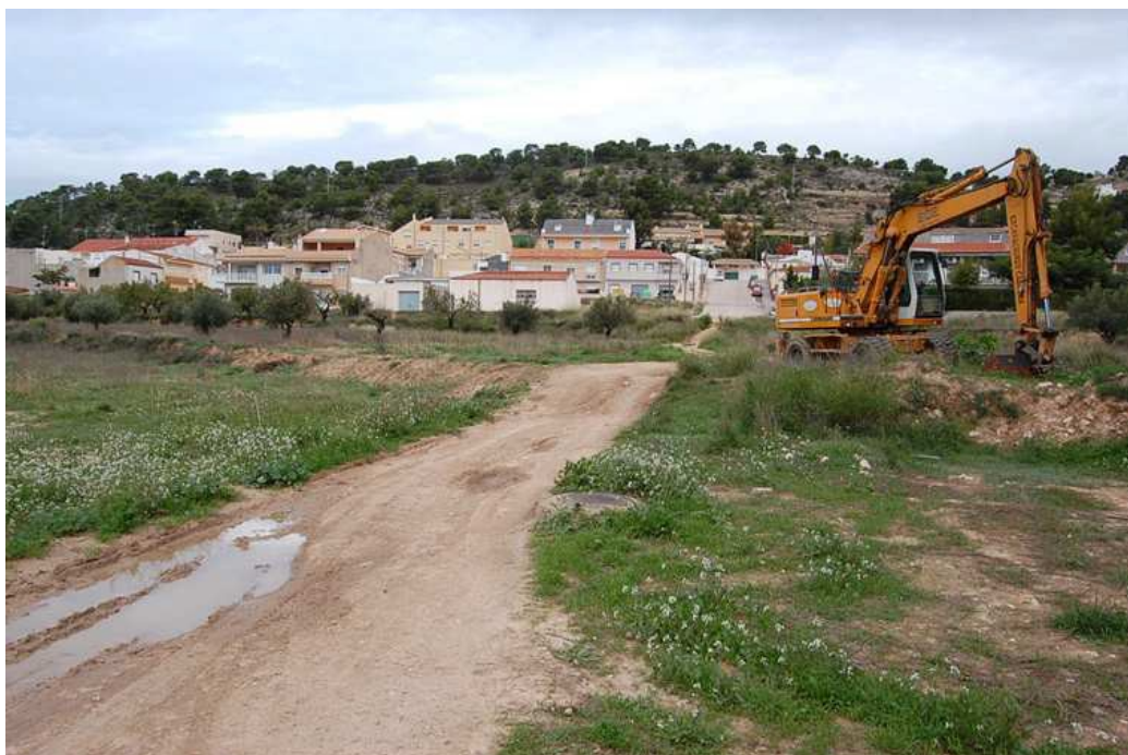
Vista general de la excavación
