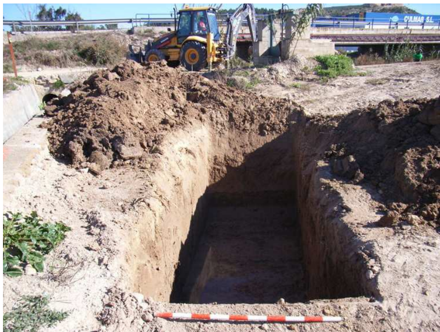
Vista del proceso de excavación de los sondeos
