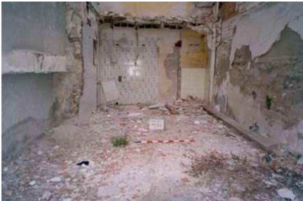
Vista previa a la excavación desde la zona norte
