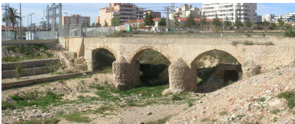
Canal y acueducto del barranco de San Antón. Vista general del acueducto aguas abajo
