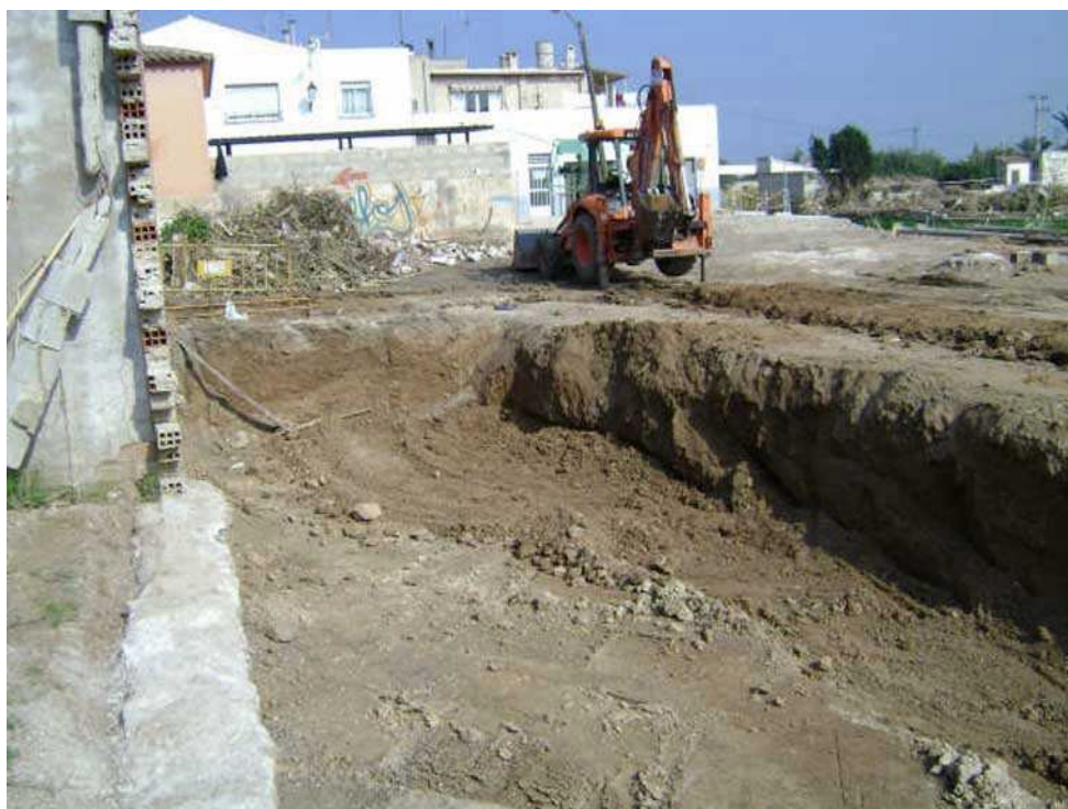
Fotografia dels treballs realitzats
