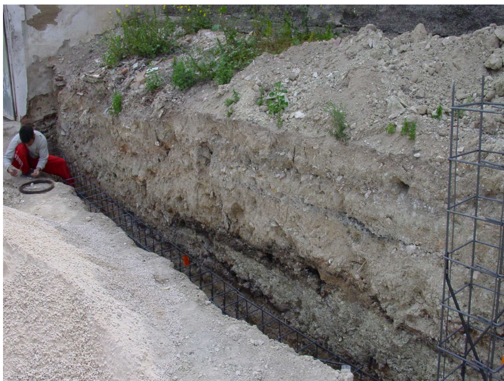
Zanja para el muro de aterrazamiento. En el perfil se observan los vertidos contemporáneos
