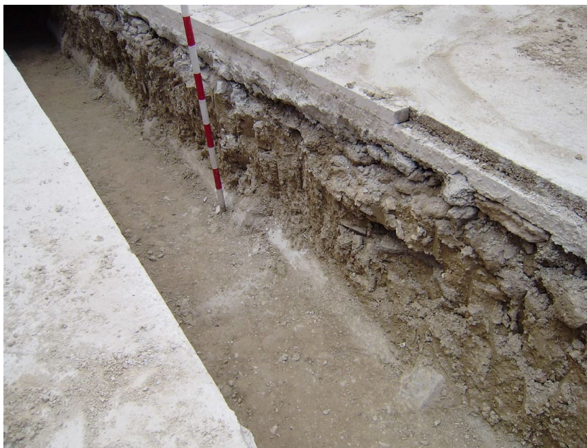
Zanja para la colocación del alcantarillado en la zona de la plaza
