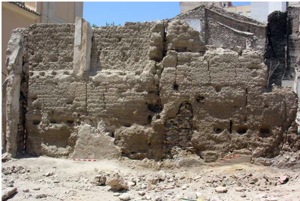
Vista del muro de tapial UE 102
