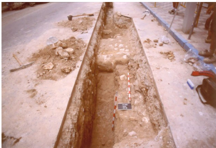
En el tramo final de la calle Colón y cerca de la calle Nueva se documentó una estructura asociada a alguna cimentación de casas de los siglos XVIII-XX
