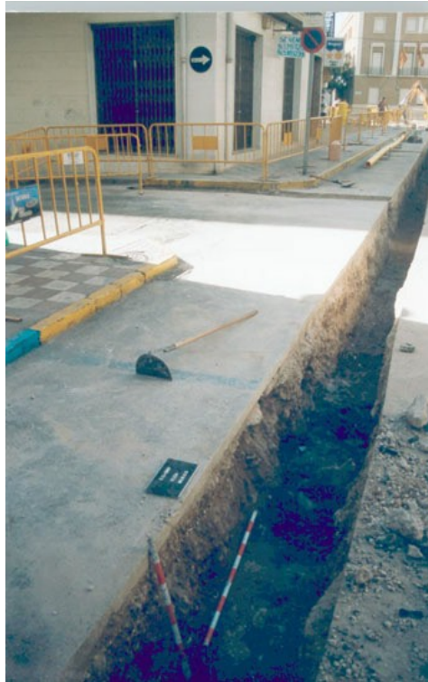
Zanja para la instalación de gas
