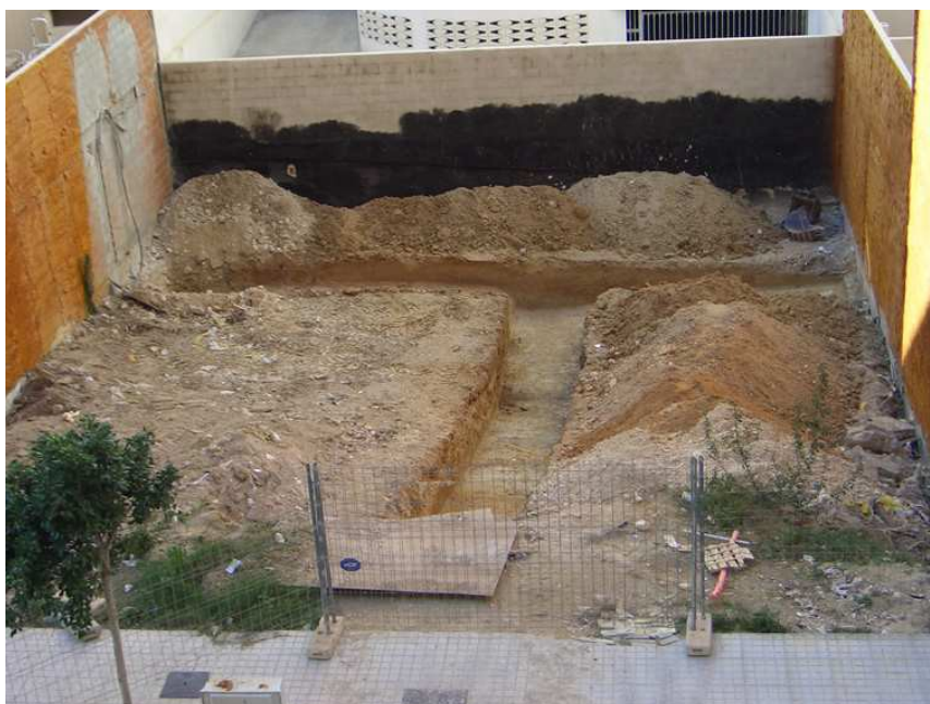
Vista final del área de actuación
